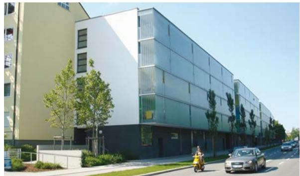
Abbildung 48: Verbesserung des Schallschutzes durch zusätzliche Abschirmung (Foto Kühne)
