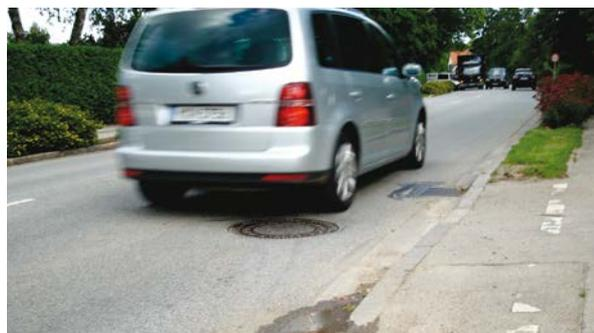
Abbildung 26: Kanaldeckel in der Rollspur als zusätzliche Schallquelle (Foto Kühne)
