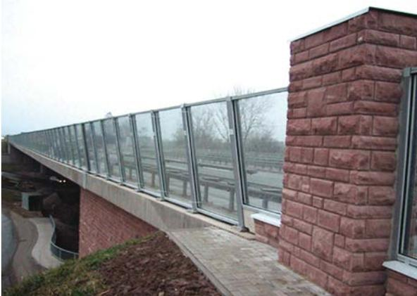
Abbildung 37: Zur Vermeidung von Schall- und Lichtreflexionen nach außen geneigte Glaswand auf einer Brücke (Foto R. Kohlhauer GmbH),
