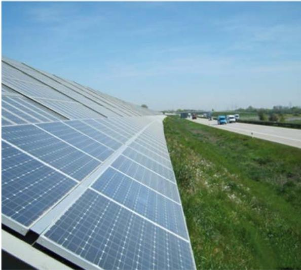
Abbildung 45: Lärmschutzwall mit aufgesetzter Photovoltaikanlage (Foto Kühne)
